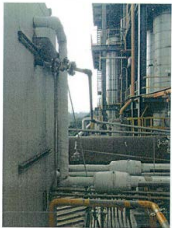
室外配管(氮氣、呼吸空氣、空調冰水管與保溫)
