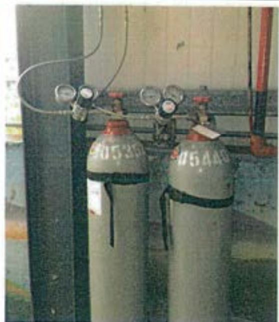
鋼瓶置放架(氮氣、標準氣體)與調壓閥
