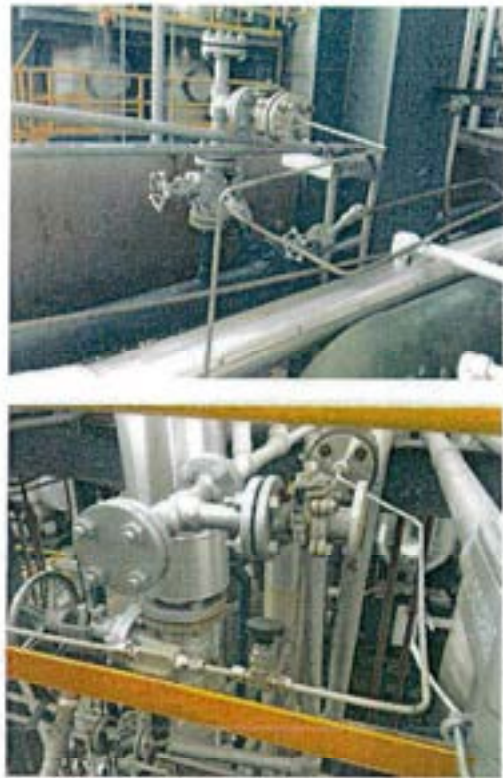
室外配管(氮氣、呼吸空氣、空調冰水管與保溫)
