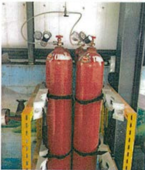
鋼瓶置放架(氮氣、標準氣體)與調壓閥
